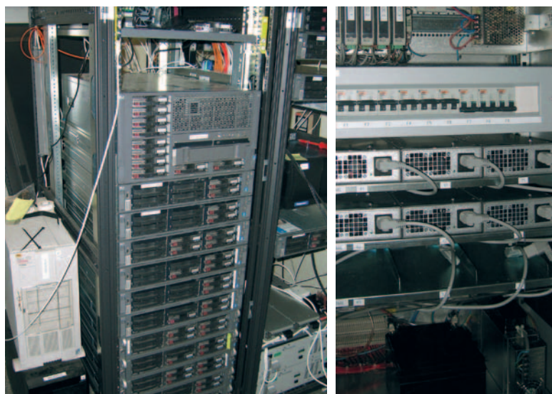
Servrarna går numera på 350 V likström. T h: Mitt i skåpet står de sex likriktarna.
